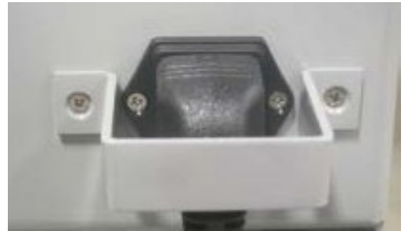
Figura 3: instalación del cable de alimentación
