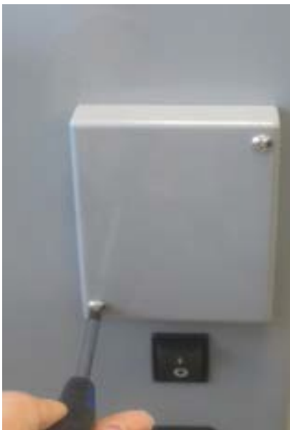
Obrázek 4: Odstranění krytu regulátoru
