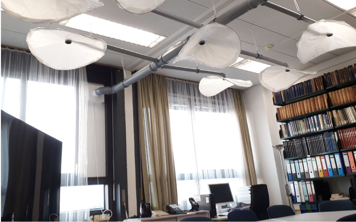
Abb. 2: Installiertes Entlüftungssystem mit Absaughauben.
